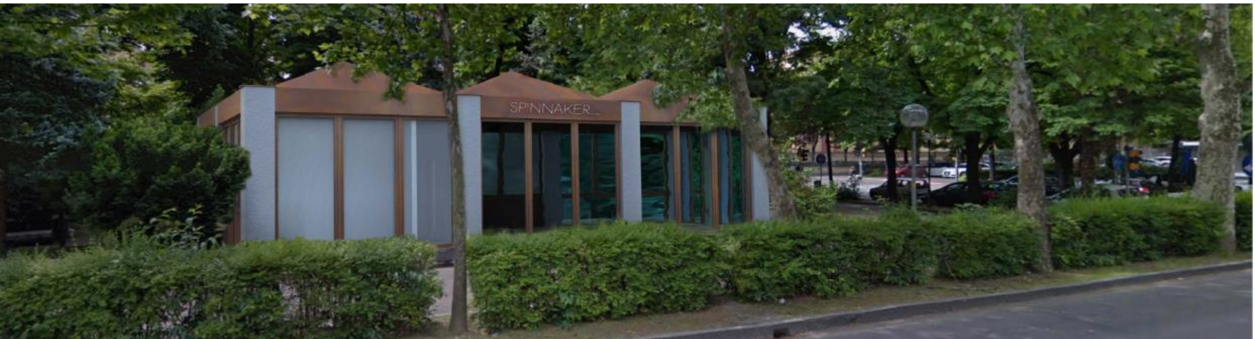
Chiosco Tosco prima della demolizione Sotto, come diventerà a lavori terminati
